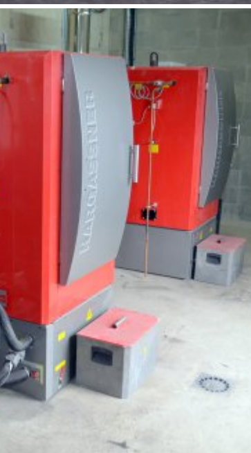
Les deux chaudières Hargassner de 100 kW à Éteignières, photo FD
