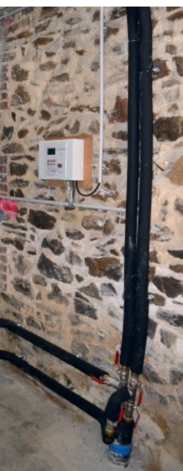
Sous-station du réseau de chaleur d'Éteignières, photo FD
