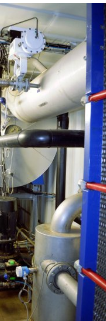
L'unité de concentration des lixiviats à partir de la chaleur de cogénération, photo FD
