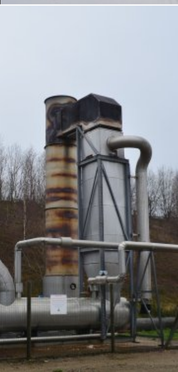
La torchère Biochaude de BIOME à Éteignières, avec récupération d'énergie, photo FD
