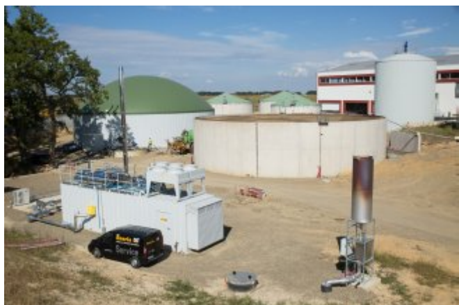
Les installations de méthanisation des Ets Labat avec le premier module de cogénération CATERPILLAR de 600 kWé installé en 2014, photo Eneria
